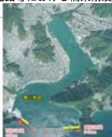
津波防波堤(須崎港)
