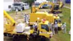
災害発生時の派遣要員養成のため、国交省および県職員・民間事業者を対象にした、災害時災害対策用機械類及び情報通信システムの操作訓練
